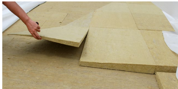
Príklad dosky SmartRoof Top 2 CTF na vytvorenie dvojspádových klínov:
